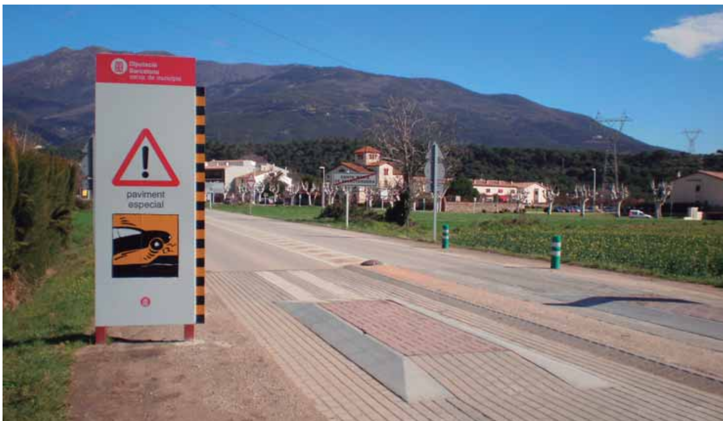
Almohada en el acceso a una travesía.
