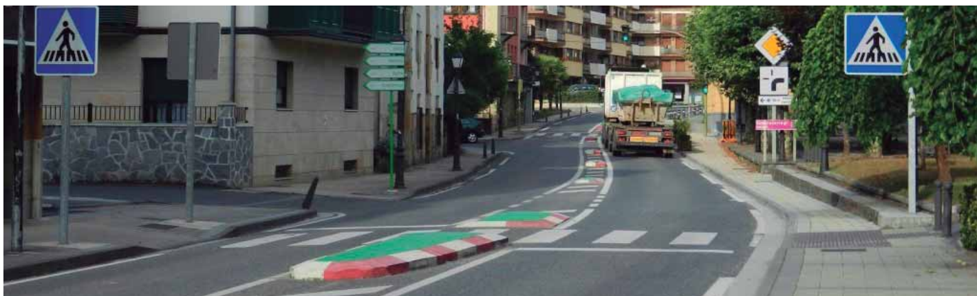
Estrechamiento mediante pintura y refugios peatonales.
