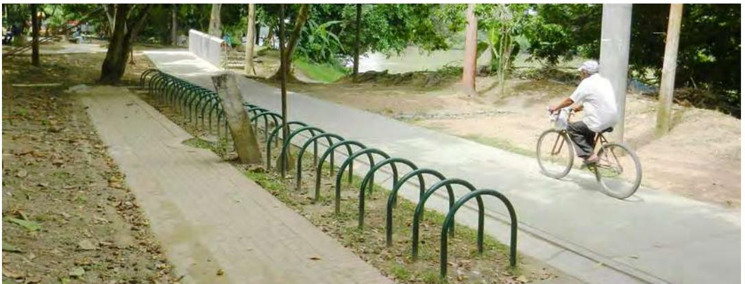
Foto 51. Estacionamiento en U invertida en Montería
