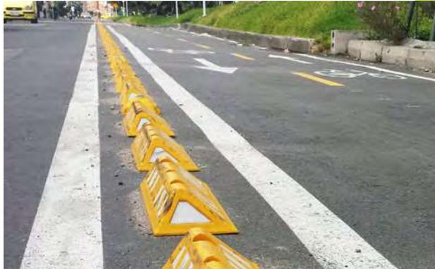
Foto 41. Ejemplo de elementos de segregación discontinuos y de baja altura (Bogotá). Fuente: Claudio Olivares Medina
