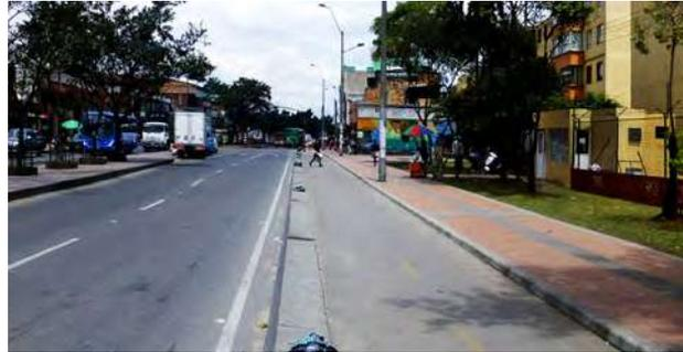
Foto 44. Ejemplo de segregación/protección con bordillo continuo (Bogotá). Fuente: Carsten Wass
