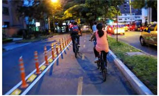
Foto 43. Segregación mixta mediante bolardos reflectantes y bordillos (Medellín)
