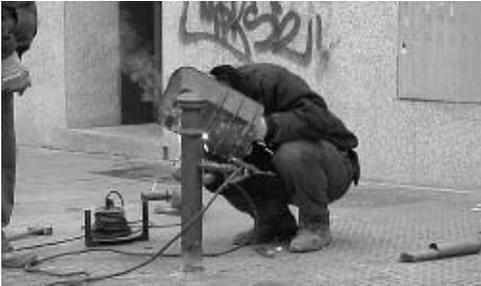
Pero es el anclaje de estos elementos su verdadero "talón de Aquiles". Los modelos prefabricados de hormigón o de piedra, así como algunos de fundición, se fijan mediante redondos corrugados o patillas de acero, que suelen ceder ante la acción de los vehículos, aunque su
