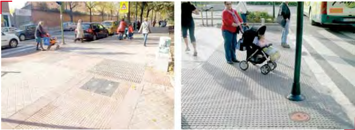
Fig. 10a y 10b: Un uso excesivo de la señalización táctil como se observa en algunas ciudades plantea la cuestión de la pérdida de significado, capacidad efectiva de orientación, coste elevado y discutibles efectos prácticos y estéticos.
