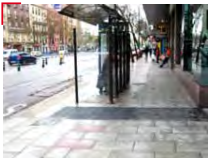
Fig.9: Pavimento señalizador marquesina.
