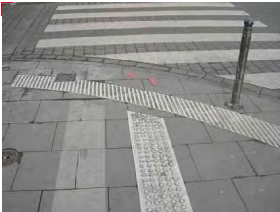
Fig.4: La falta de estandarización en el uso de la señalización táctil genera diferentes códigos en países, regiones y ciudades. En la foto, sistema de señalización de paso de peatones en Colonia, Alemania.
