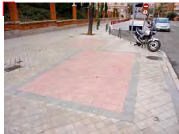
Fig. 11: El uso excesivo de la pavimentación táctil también conduce a vaciar su significado generando aplicaciones simplemente ornamentales o de otro tipo.
