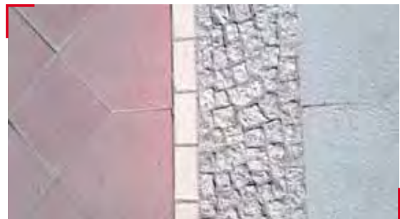
Fig. 16: Franja con un pavimento táctil para segregar banda ciclista y espacio peatonal.
