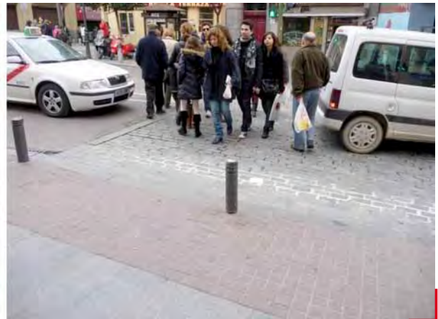
Fig. 8a y 8b: Falta de uniformidad del pavimento táctil y dificultad de discriminación entre materiales. Las soluciones no estandarizadas en zonas escogidas de la ciudad, pueden resultar más estéticas, pero son poco efectivas.
